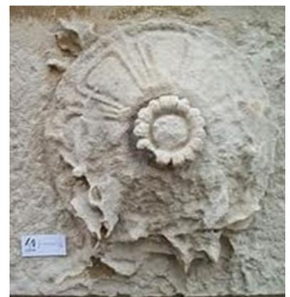
Figura 1: Detalle de adorno degradado (Stec Ierm, 2018).
